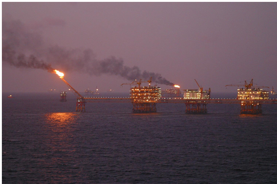
Die Industrialisierung der Meere schreitet voran. Ölplattformen vor Vung Tau, Vietnam.
